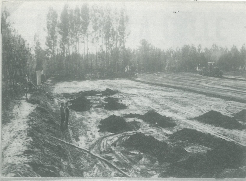
Iniciación de las obras de movimiento de tierras.
